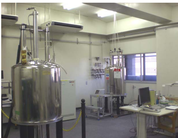
装置を受け入れる NMR 室
